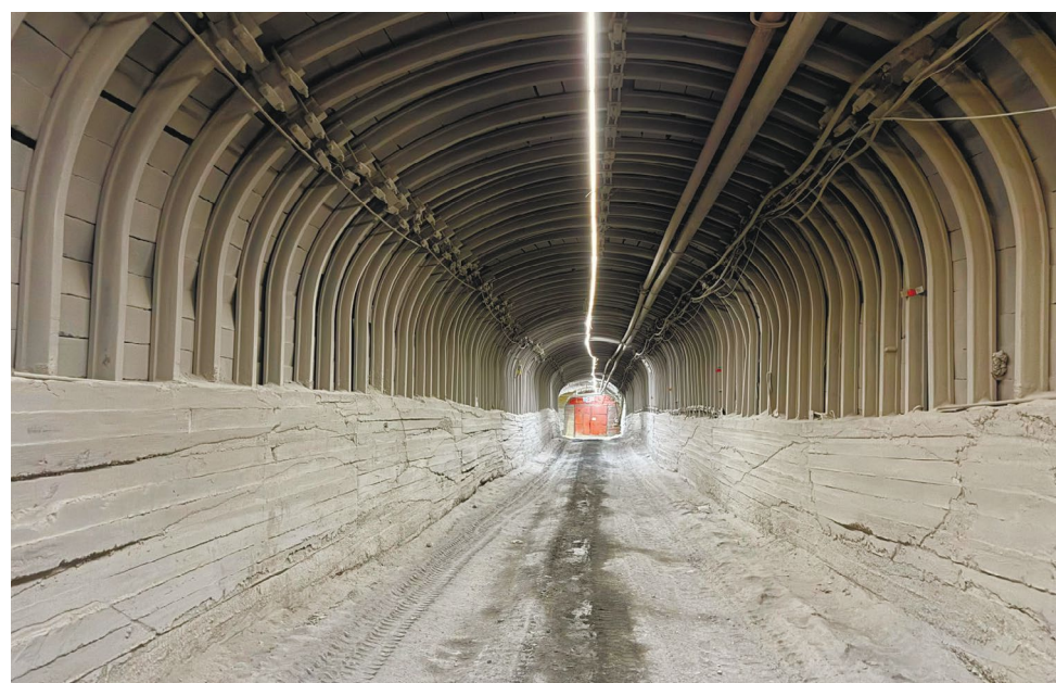
Подземный склад. Горизонт «минус 850 м» рудника «Скалистый» Заполярного филиала ПАО ГМК «Норильский никель»
