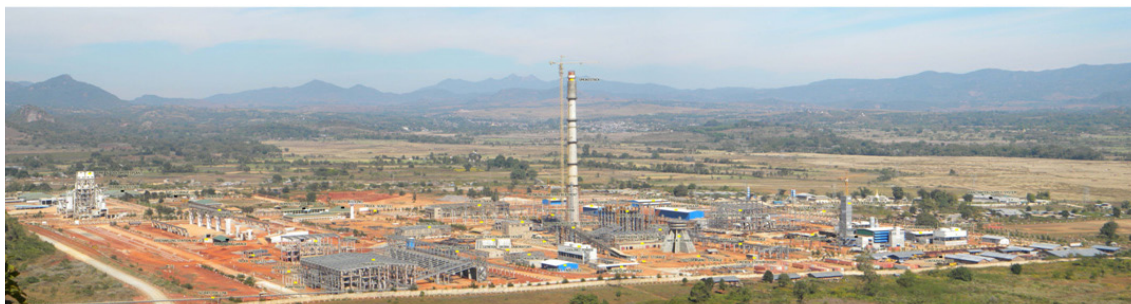
Панорама строящегося завода Ромелт в Республике Союз Мьянмы
