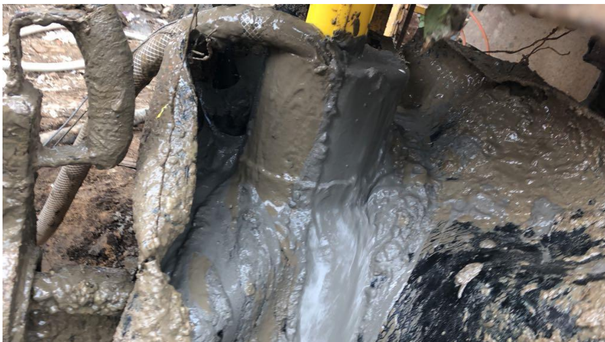
Рисунок 2.20 – Фотофиксация заполнения скважины универсальным заменителем грунта
