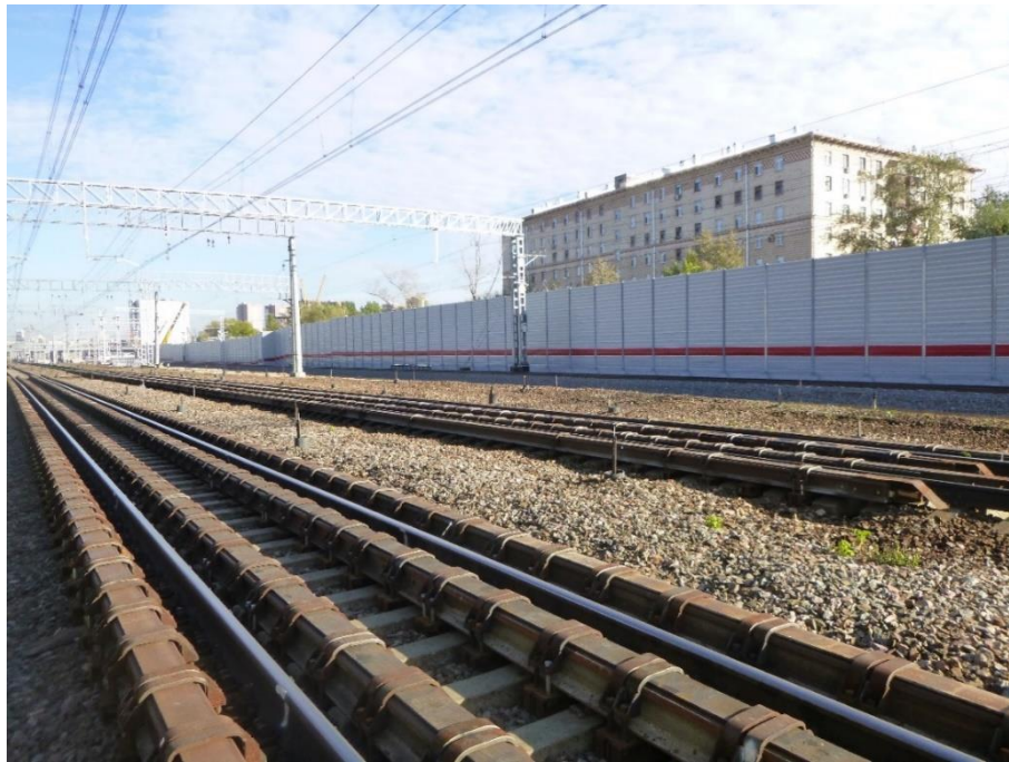
Рисунок 2.10 Фотофиксация страховочных пакетов, установленных на железнодорожные пути
