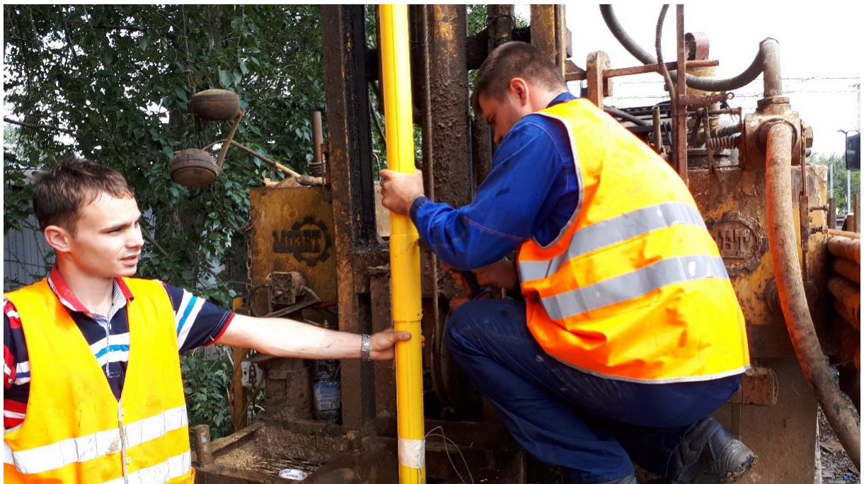
Рисунок 2.19 – Фотофиксация обустройства пробуренной скважины под измерительное оборудование
