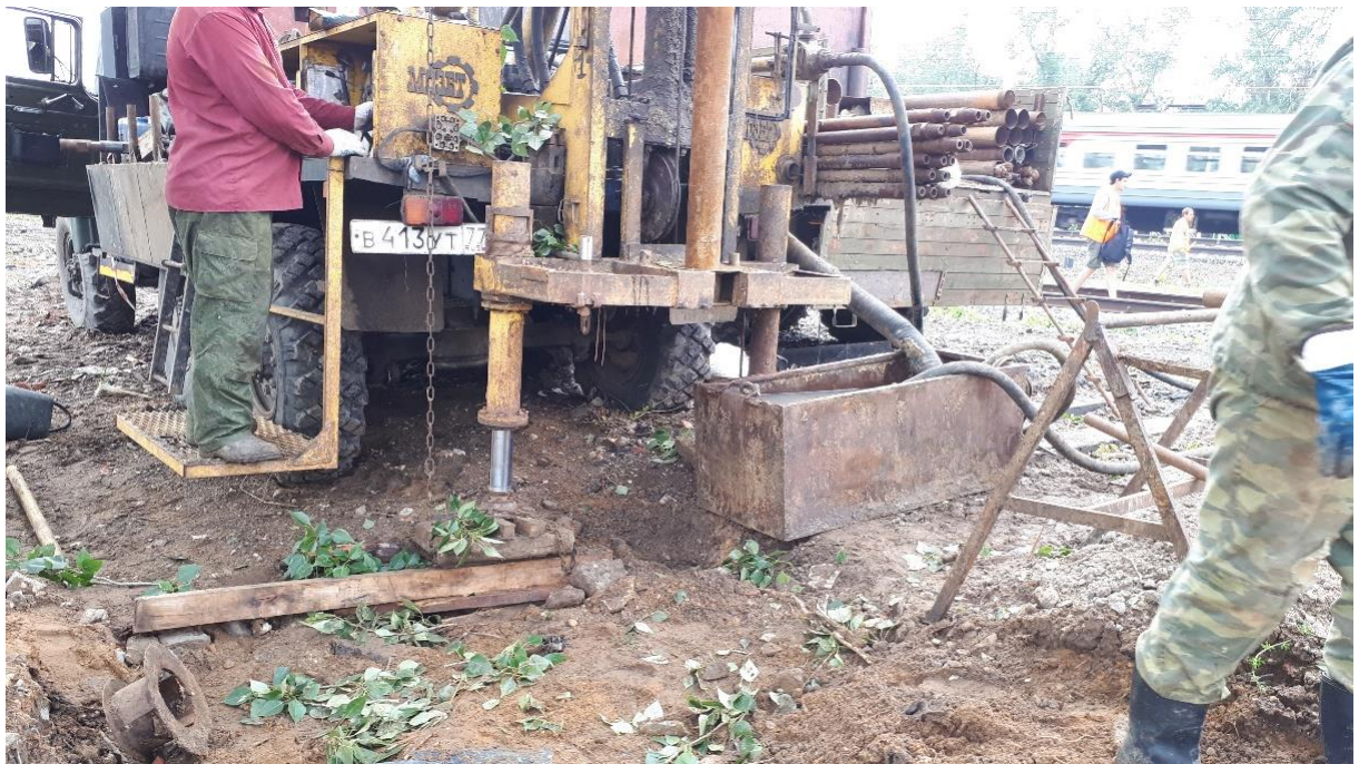
Рисунок 2.18 – Фотофиксация бурения скважины до проектной отметки
