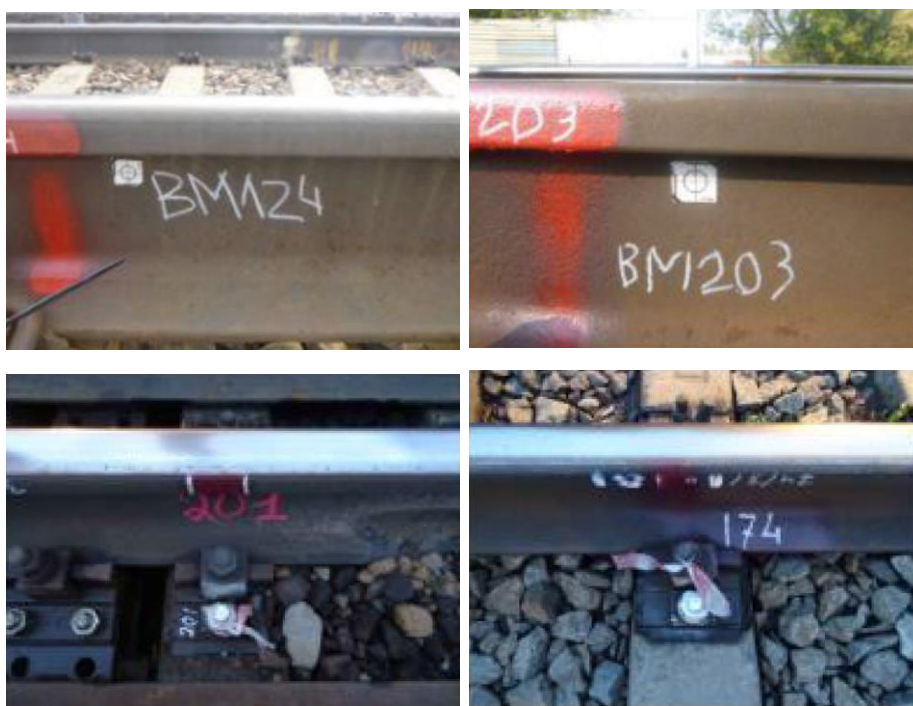
Рисунок 2.9 Фотофиксация деформационных марок, установленных на рельсах железнодорожного пути
