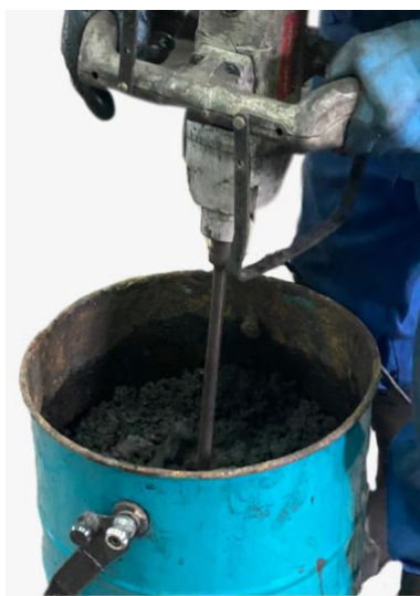
Рисунок 15 – Процесс приготовления почвогрунта с помощью турбинной мешалки
