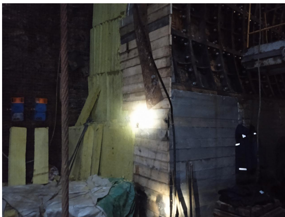
Рисунок 4.12 – Возведение податливого слоя из минераловатных плит в крепи сопряжения ствола №3. УКК
