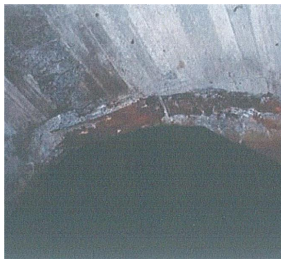
Рисунок 1.10 – Деформационные процессы в крепи сопряжений горизонтальных околоствольных выработок со стволом (глубина Н=600м).
