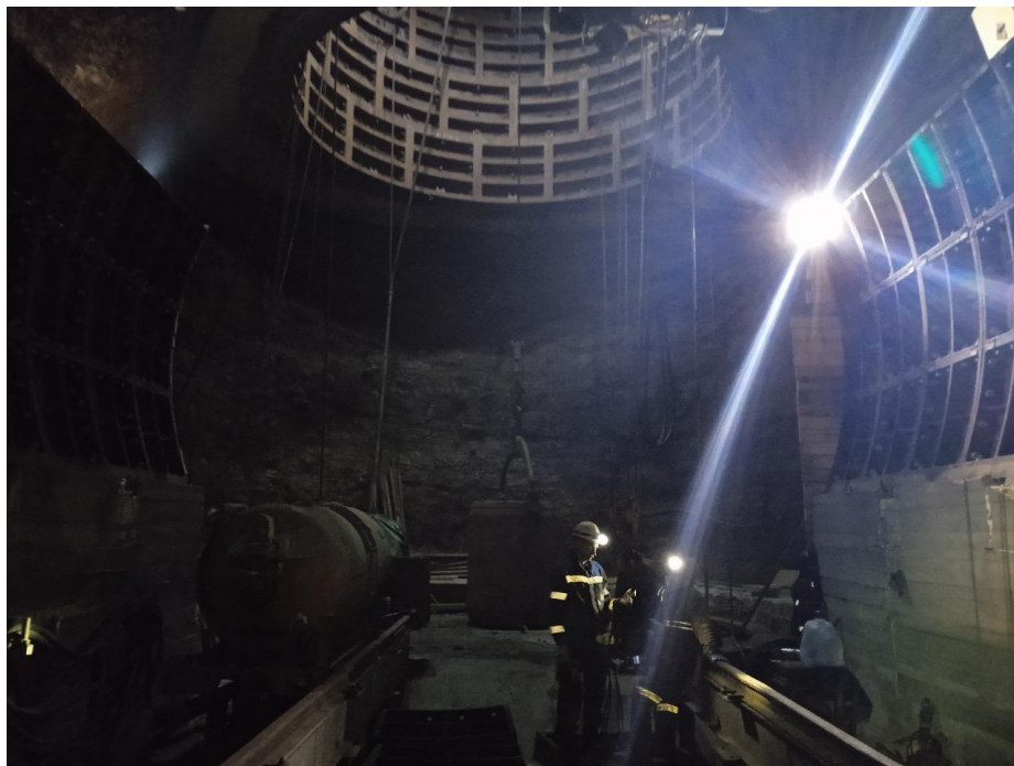
Рисунок 4.11 – Возведение крепи сопряжения ствола №3. УКК
